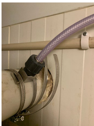
Injektion AveFerm i tvärskruv
